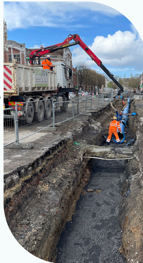
Renouvellement duc réseau d'eau Av. Gambetta à Tourcoing
