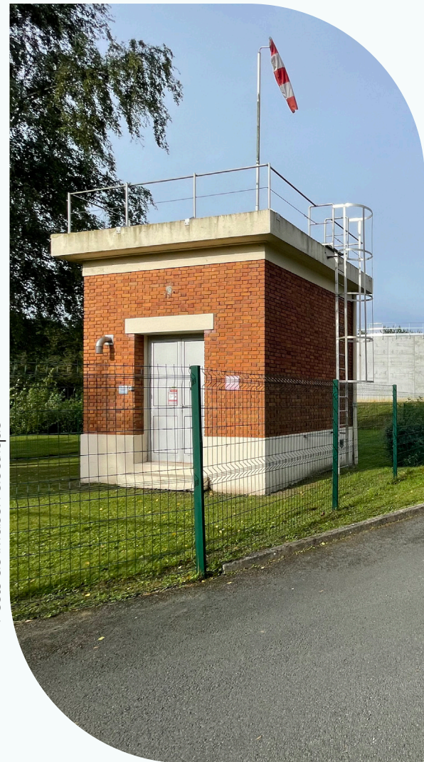
Poste de livraison électrique
