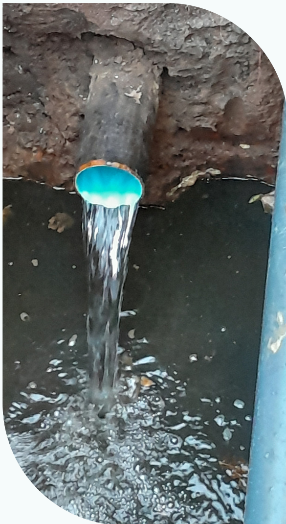
Régénération de la conduite par projection de résine/ Lille rue de Finlande.
